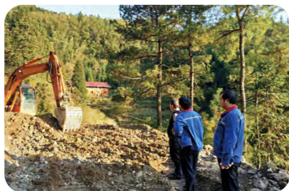
产业路施工督查
