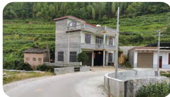
◆ 进村大桥改造后
