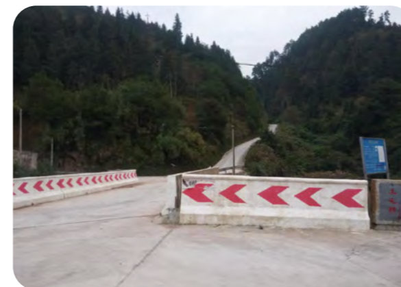
2020年，完成危桥改造工程。
