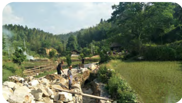
◆ 二联村河道治理
