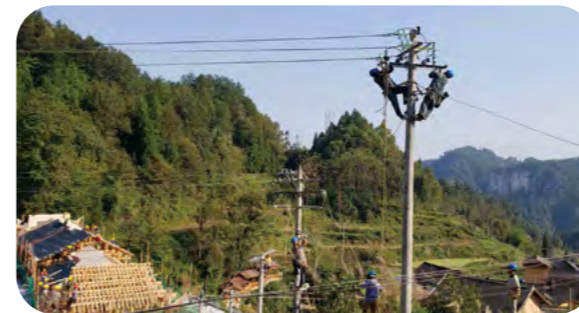
公司员工在进行农网改造，有时会夜间作业。
